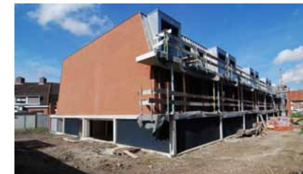
Binnenblok is half opgetild boven verdiepte parkeergarage
